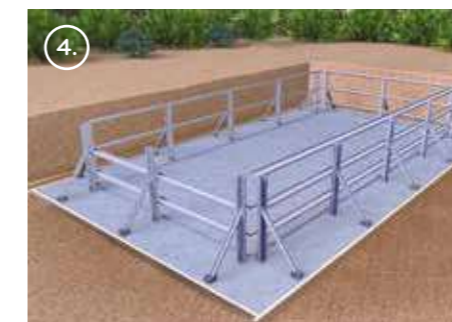
4. Poser les panneaux (cliquer + revetter)
