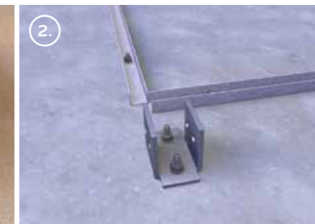
2. Fixer les profils U sur la dalle
