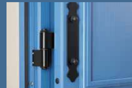
Détail montage gonds sur précadre
