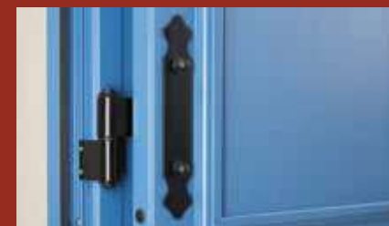
Détail montage gonds sur précadre
