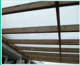
Couverture en tôle polycarbonate transparente
