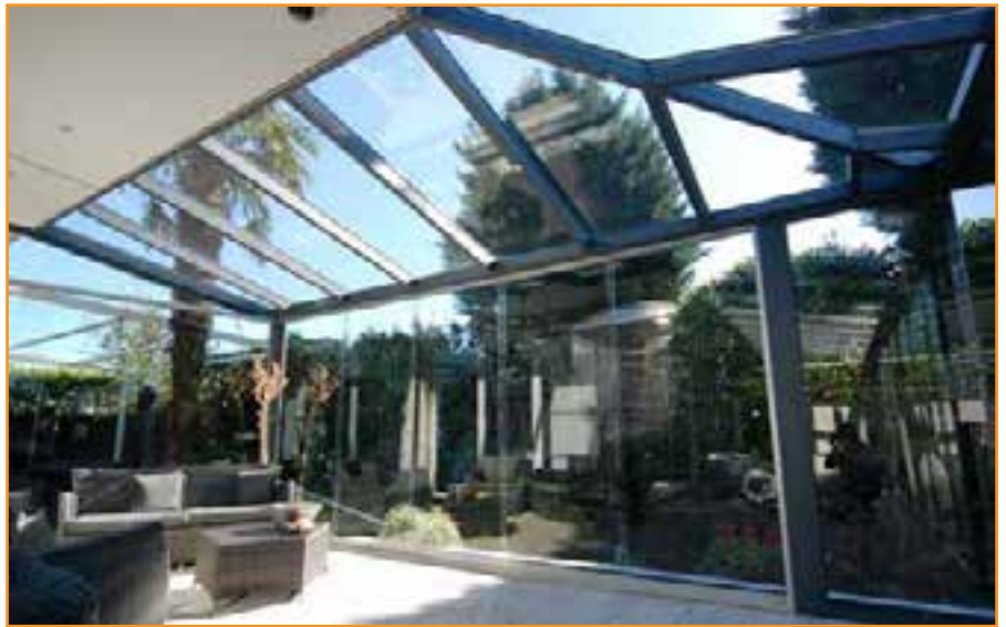
Jardin d'hiver avec store sous toitures se prolongeant dans l'auvent de l'habitation
