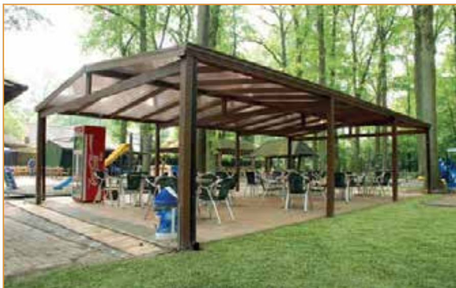
Toiture double pente pour établissement de restauration
