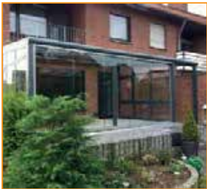
Pergola avec entrée séparée vers l'avant de l'habitation
