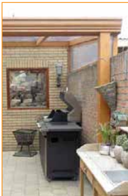
Pergola réalisée en structure bois
