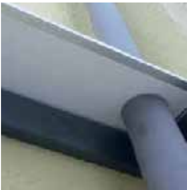
Evacuation des eaux de pluie à travers le toit
