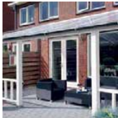
Balustrade de pergola
