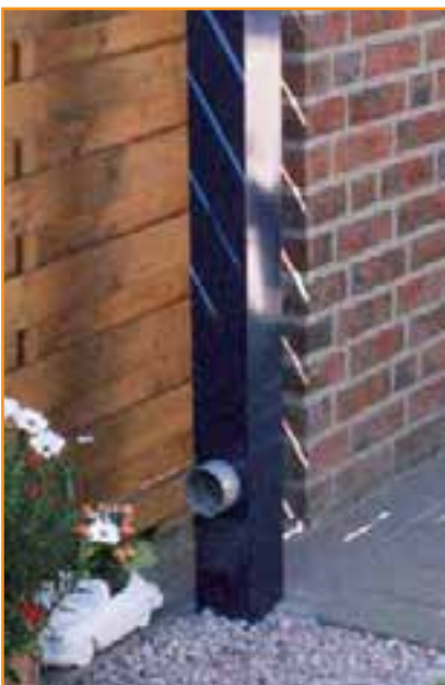
Evacuation des eaux de pluie en surface
