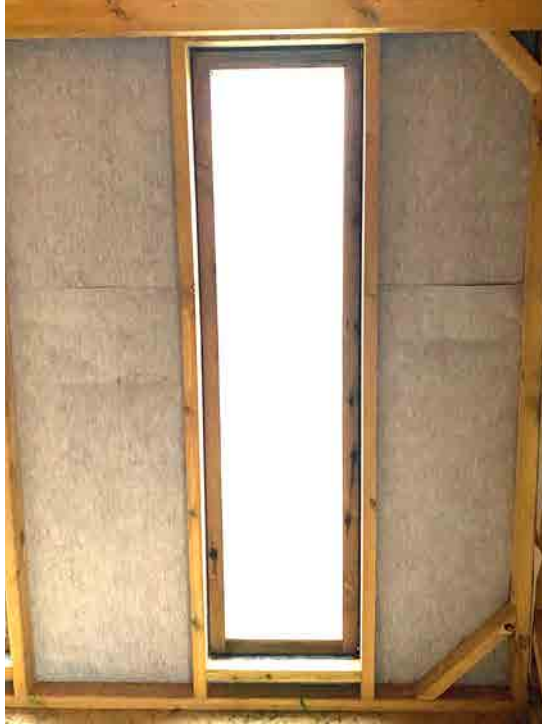
Un doublage par un pare-pluie assurant l'étanchéité des murs
